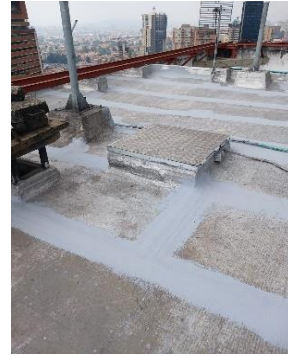
Terraza torre C
